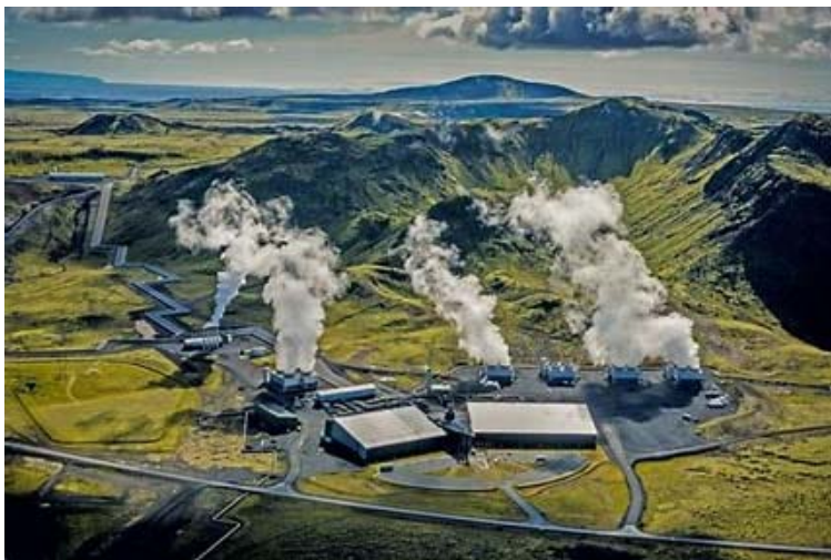
Flächenbedarf einer Anlage der Firma Climeworks auf Island
